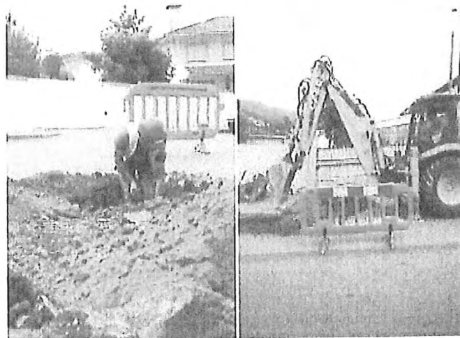
Obra da Vimágua em setembro de 2016 O investimento em infraestruturas é contínuo
